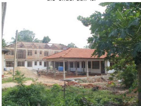
17 December 2013 Dakconstructie van het deel wat twee verdiepingen telt
