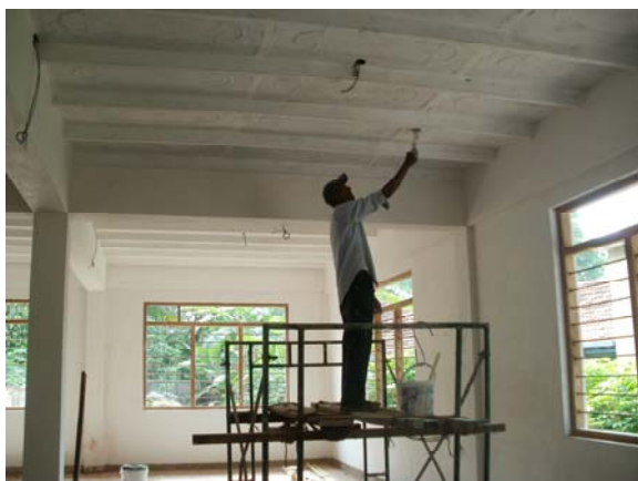
November 2013 Werken aan de plafonds in de vleugel die 'onder dak' is.
