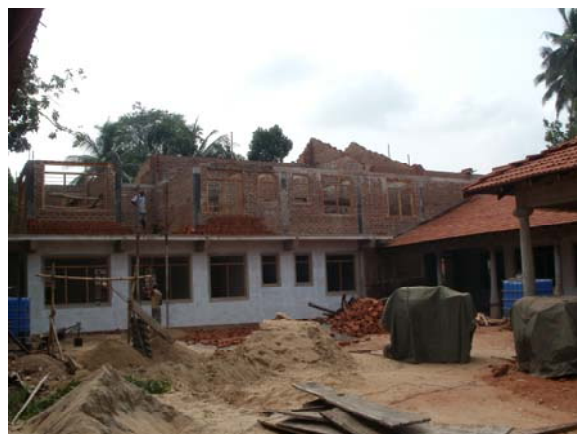
November 2013 De tweede verdieping
