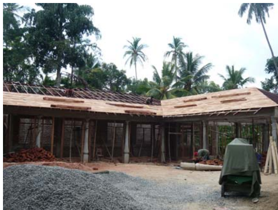
16 Oktober 2013 De dakconstructie wordt gemaakt.
