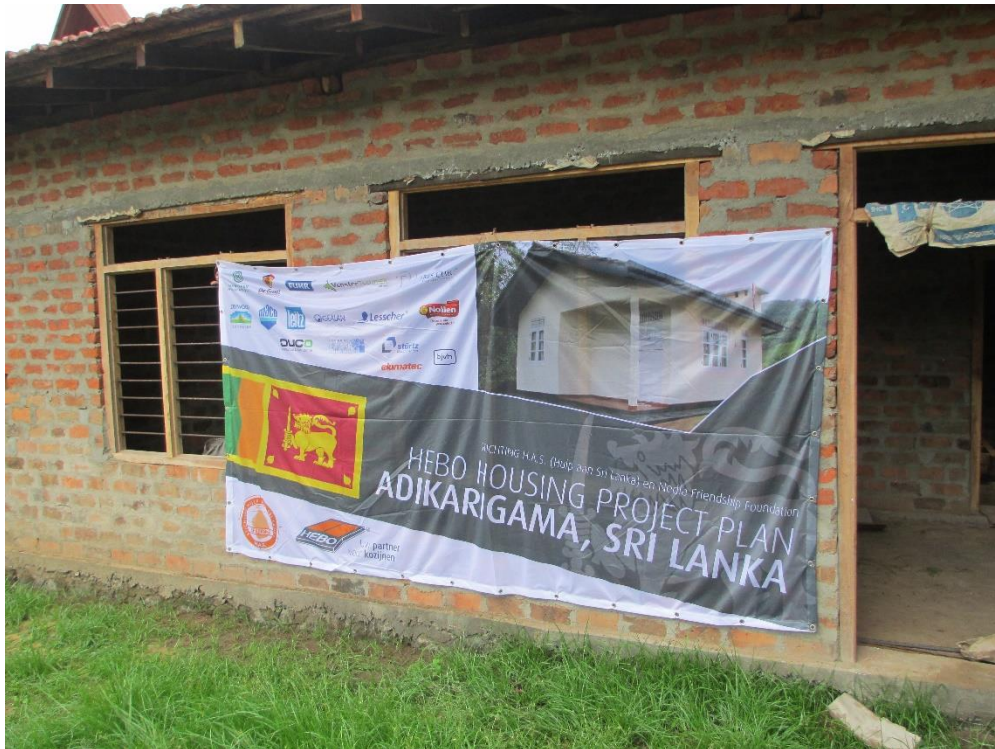
13 november 2016: Het spandoek wordt op de bouwplaats opgehangen.
