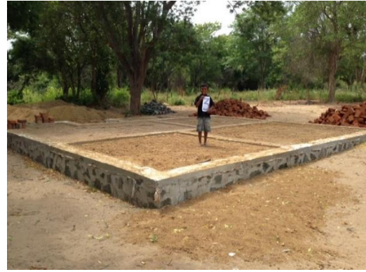
30 juli 2016: Er wordt gestart met de bouw van het derde huis.
