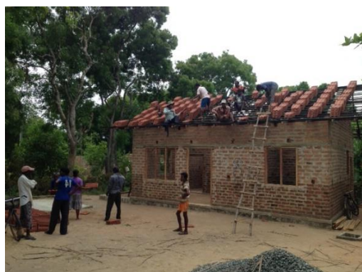
15 juli 2016: Er worden dakpannen gelegd op het eerste huis.
