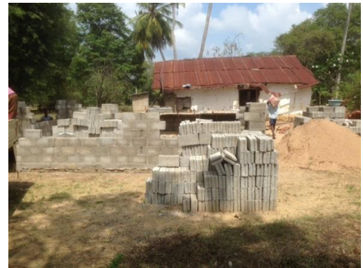
2 november 2016 Bouw van het vierde huis
