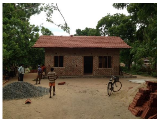
Na een dag hard werken is het dak dicht.
