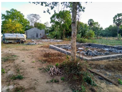
10 juli 2019: Overzicht van de bouwlocatie
