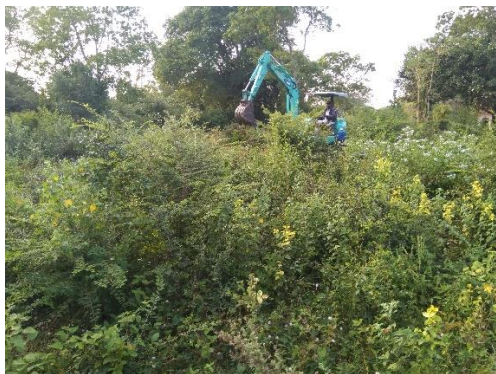
6 januari 2019: Start met het bouwrijp maken van de grond waar de huizen gebouwd worden.
