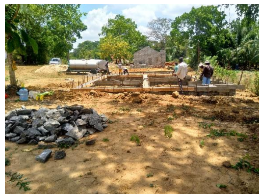
11 juli 2019: Overzicht op bouwlocatie
